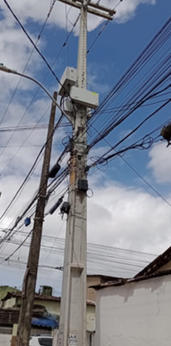
Terminal de Leitura Individual, tipicamente instalado no padrão de entrada da Unidade Consumidora (onde ficava o medidor convencional)
